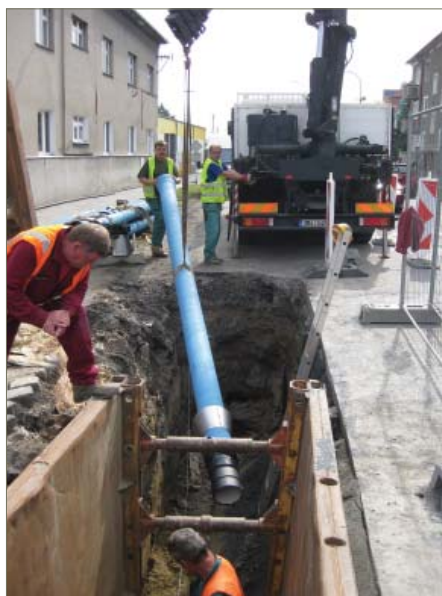
Spouštění potrubí do startovací montážní jámy, stavba Litovel
