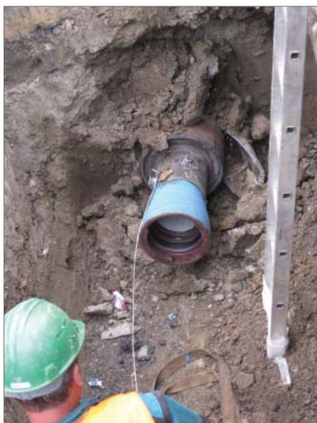
Montáž potrubí, stavba Litovel
