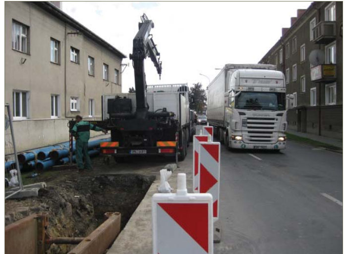
Pokládka potrubí za plného provozu, stavba Litovel
