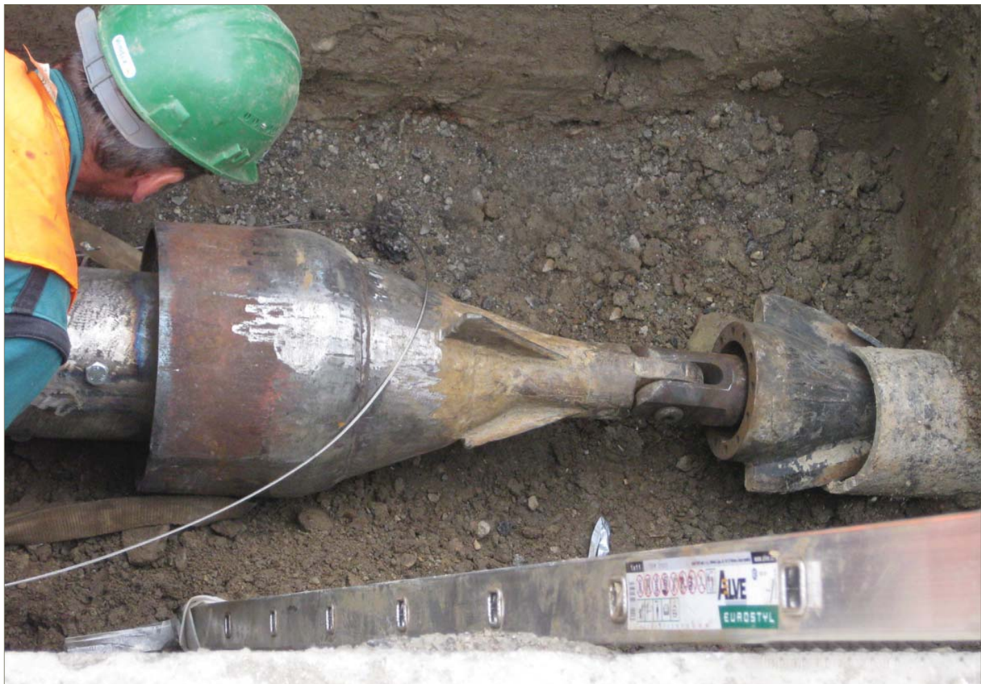
Trhací hlavice zajiždí a rozbíjí stávající potrubí z šedé litiny, dále následuje rozšiřovací hlavice s potrubím, stavba Litovel
