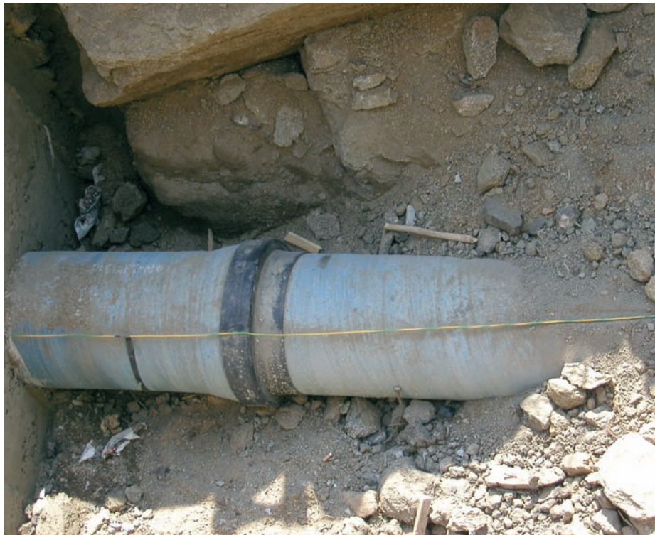
obr. 2 – Varianta zásepů potrubí OCM/ZMU
