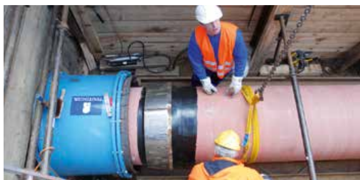
Relining dlouhých úseků
