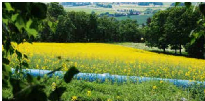
Dočasné (provizorní) potrubí se spoji BLS®
