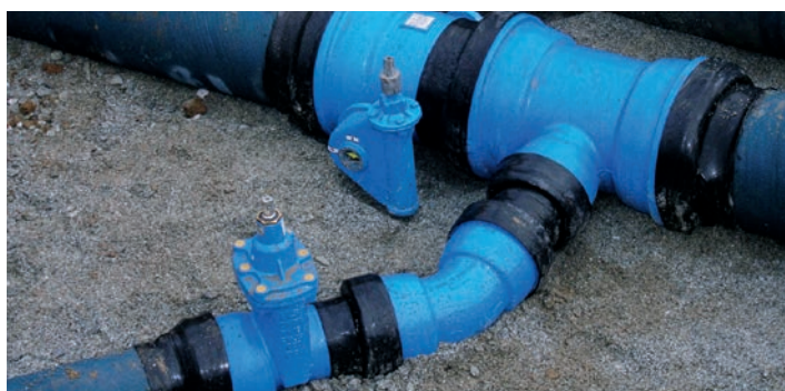
Tvarovky BLS® s klapkou a šoupátkem
