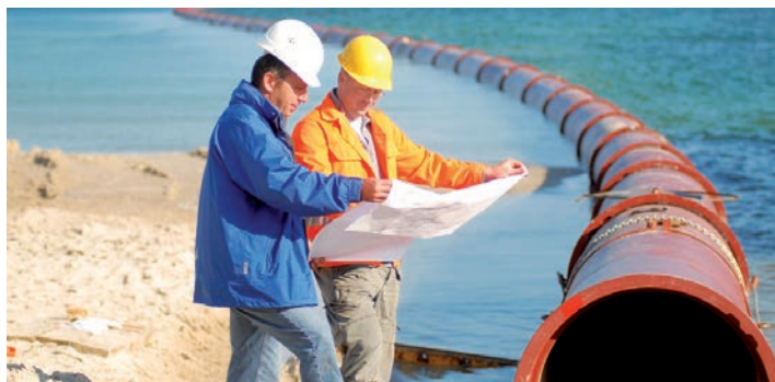
Vtahování potrubí z tvárné litiny se spoji BLS® v zatopeném kanálu
