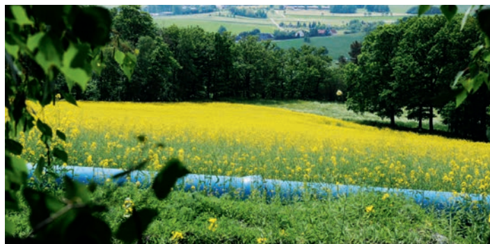
Dočasné (provizórne) potrubie so spojom BLS®.
