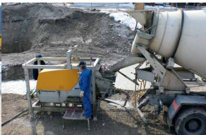
Injektáž betonu do prostoru kolem pláště piloty se provádí současně s jejím zarážením
