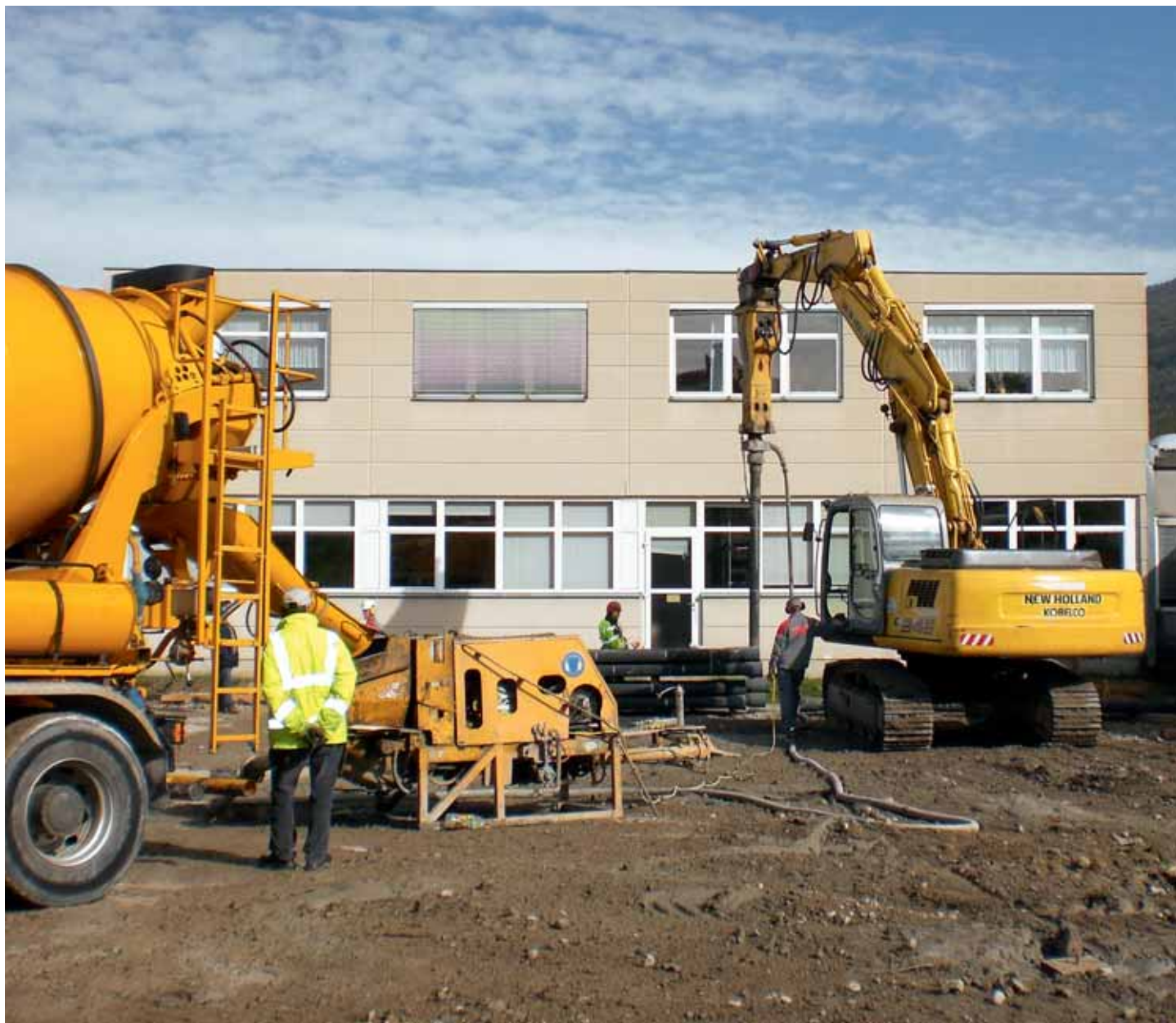
Rozšiřování závodu v centru rakouského Salzburgu, beraněné piloty z tvárné litiny vtlačované do betonu o délce až 59m nesou zatížení 800 kN
