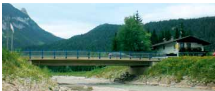
Protipovodňová ochrana Leutascher Ache – Rakousko – ekologické zhodnocení říčního úseku
