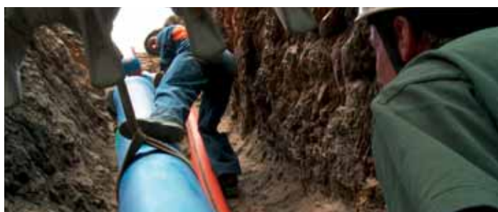
Pokládka na strmém svahu se sklonem až 85°
