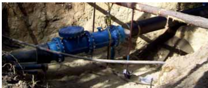
Přírubová tvarovka pro montážní otvor a připojení hydrantu
