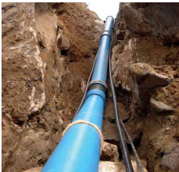
Pokládka trouby na skalnatém svahu
